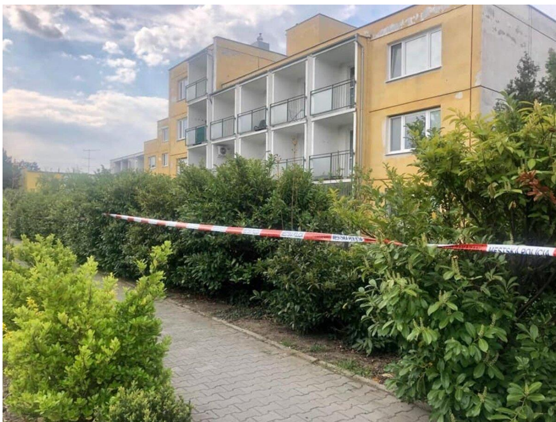
Okolo budovy zariadenia bolo vytvorené ochranné pásmo. (Zdroj: MŽ)
